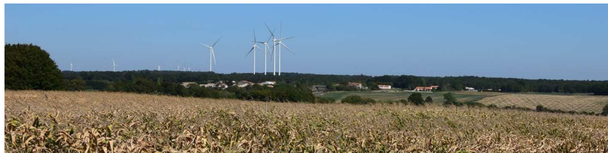
Éoliennes existantes de Fontenille et Salles Villefagnan depuis la D56 à Fontclaireau
